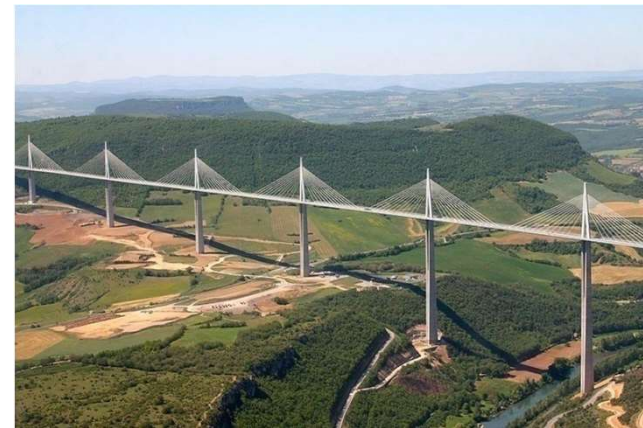
Viaduc de Millau
